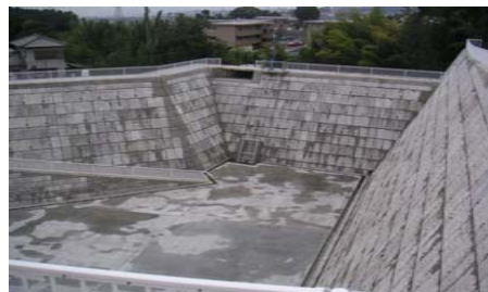
<調整池の北東側から南西側を望む>
